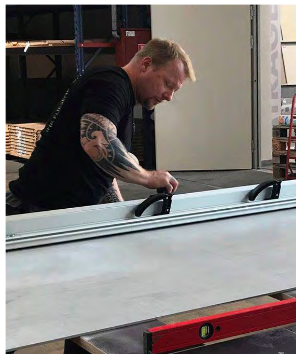
Meusel beim Fließenschnitt.
